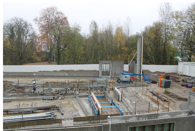
Chantier de la 2 ème tranche | Prémurs et structures béton
