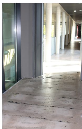
Campus de la Meinau Rénovation des sol dans les bureaux et les espaces de circulation (printemps et automne 2021)
