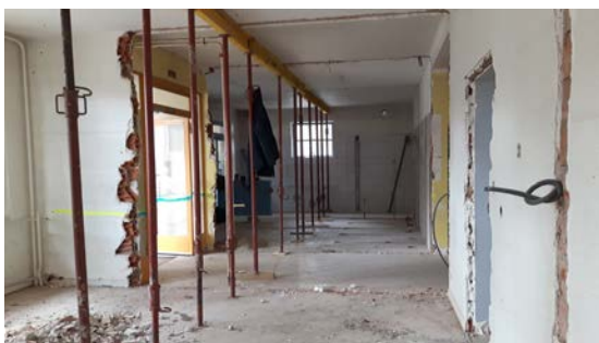
Bibliothèque (en cours de travaux)
